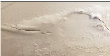
Exemplo de criptoflorescência (ou subflorescência) num reboco de uma parede térrea
