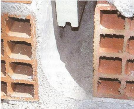
Pormenor de base de parede dupla exterior com isolamento térmico/acústico, lâmina de ar e caleira (http://isolar.pt/ficheiros/file/Dow\_Portugal\_Paredes.pdf)
