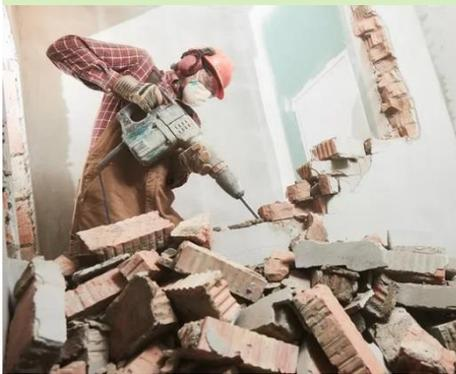
Figura 26. Exemplo de desconstrução de parede de alvenaria de tijolo, com separação dos tijolos, possibilitando a sua reutilização (adaptado de Hamilton Demolition, <https://www.hamiltondemolition.ca/selective-demolition>)
