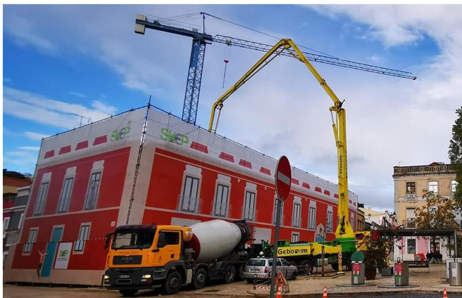
Figura 27. Exemplo de obra com telas de proteção de andaimes reproduzindo o aspeto das fachadas no final da obra (SKEP S.A.)
