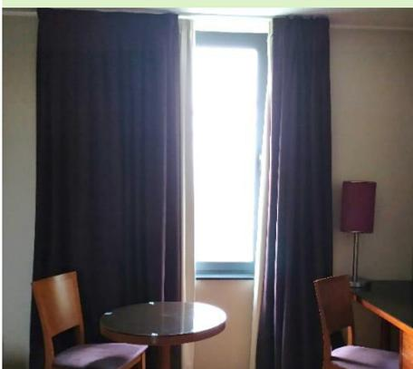
Figura 20. Envidraçados orientado a sul com janelas com abertura limitada, sem proteção exterior e com blackout e cortinado interior
