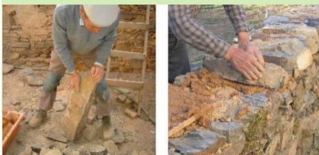
Figura 19. Exemplo de contratação de “mestre” local especializado da execução de paredes de alvenaria de xisto assente com argamassa de terra, Cachopo, Tavira
