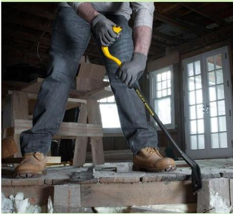
Figura 25. Exemplo de desmantelamento de piso em madeira com ferramentas ligeiras (adaptado de Stanley, <https://www.stanleyworks.pt/>)
