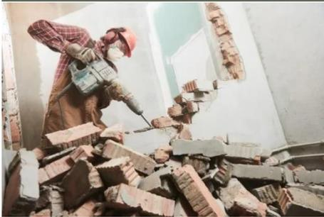
Exemplo de desconstrução de parede de alvenaria de tijolo, com separação dos tijolos, possibilitando a futura reutilização (<https://www.hamiltondemolition.ca/selective-demolition>)
