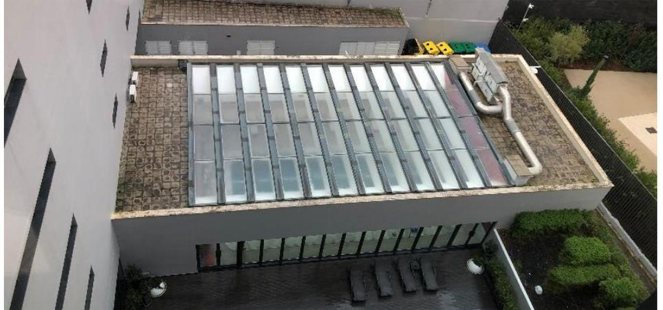
Figura 4. Cobertura plana de acessibilidade limitada com área translúcida para iluminação natural da zona da piscina interior
