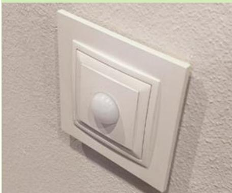
Figura 18. Exemplo de sensor de movimento em zona de circulação, para acionamento de iluminação em corredor de acesso a quartos
