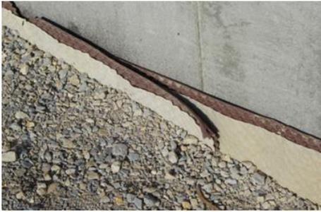
Exemplo do sistema de proteção do sistema de estanquidade aplicado a uma parede parcialmente enterrada
