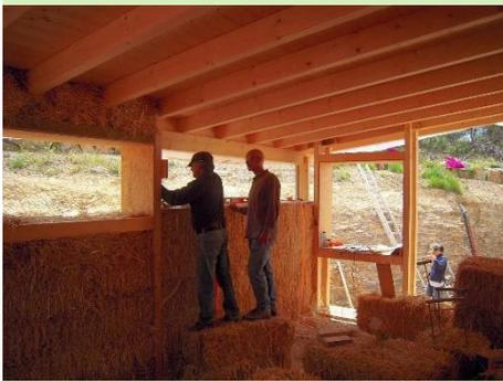
Figura 3. Ampliação de habitação, com estrutura de madeira e paredes em fardos de palha, Aljezur (adaptado de Terrapalha, Lda, <https://terrapalha.com/>)
