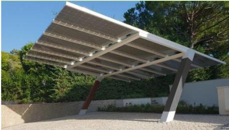
Figura 16. Painéis fotovoltaicos integrados em pórtico de sombreamento de zona de estacionamento ao ar livre (adaptado de Solar Power, <https://www.solarpower.pt/>)
