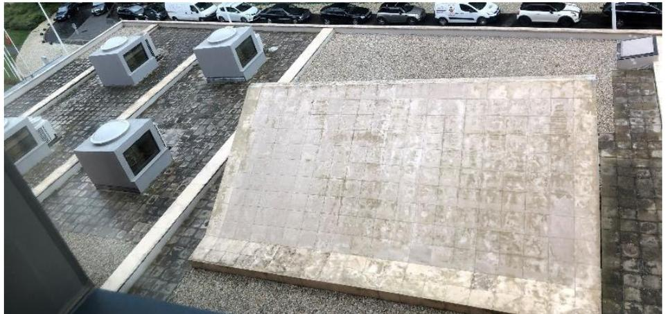
Figura 6. Cobertura plana de acessibilidade limitada sobre o piso térreo, com clarabóias para iluminação natural e onde ocorrem problemas de infiltrações
