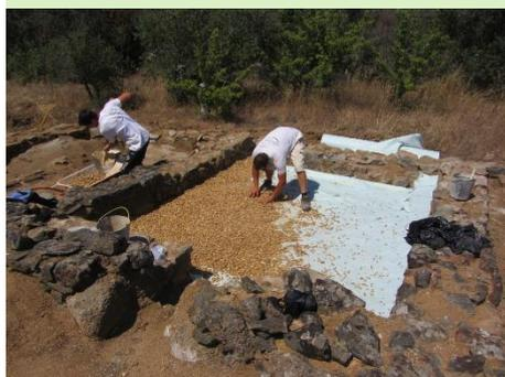
Figura 22. Exemplo de proteção de estruturas arqueológicas com geotêxtil e camada de gravilha
