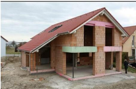
Exemplo de isolamento térmico aplicado nas vergas sobre vãos exteriores para minorar as pontes térmicas planas (<https://www.hausbauen24.eu/>)
