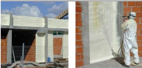
Exemplo de aplicação de espuma de poliuretano, por projeção, em parede dupla exterior
