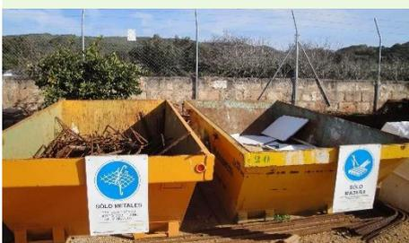
Figura 21. Exemplo de implementação de sistema de separação de RCD (adaptado de Ferrovial, <https://blog.ferrovial.com/en/2019/05/recycle-construction-site/>)
