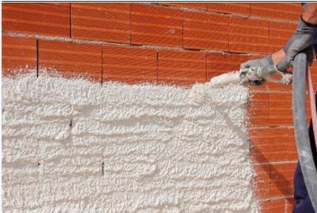
Exemplo de aplicação de reboco térmico por projeção (<http://www.fontainhasrevest.com/pt/component/k2/item/80-isodur-isolamento-termico-projectado>)
