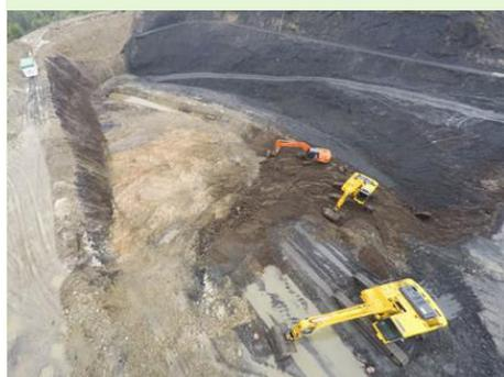
Figura 23. Exemplo de trabalhos de remoção de solos contaminados (adaptado de Ecodeal, <https://www.ecodeal.pt/portefolio-ecodeal>)
