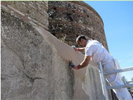
Figura 24. Exemplo de consolidação de rebocos antigos com aplicação de argamassa à base de cal
