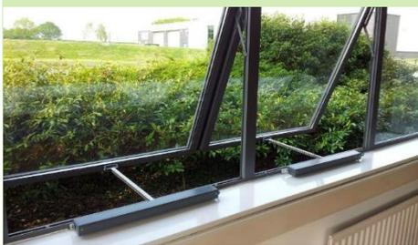
Figura 10. Exemplo de janelas projectantes, com controlo de abertura (adaptado de Airtherm Flue Systems Limited, <http://airtherm.co.uk>)
