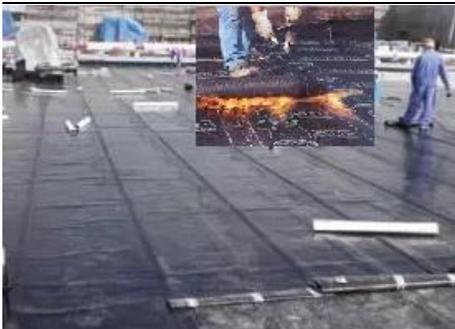
Exemplo de aplicação de membrana de betume-polímero em cobertura plana (<https://www.soprema.pt/pt/impermeabilizacao-betuminosa>)
