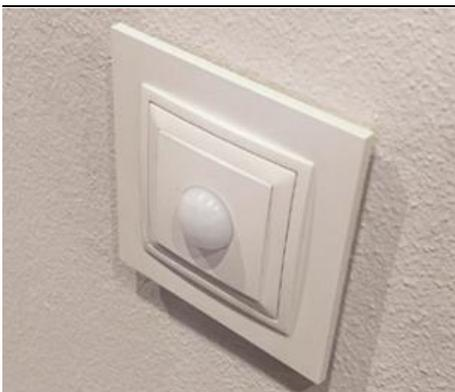
Exemplo de sensor de movimento para controlo de sistema de iluminação
