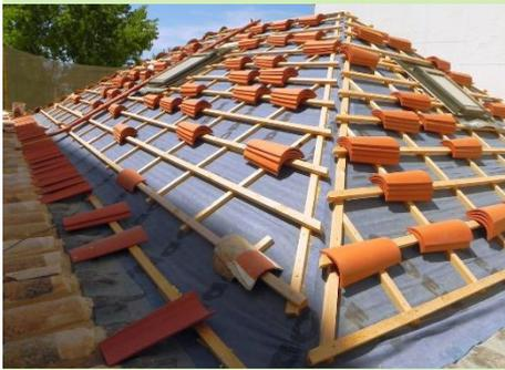
Figura 20. Exemplo de reabilitação de cobertura, planeada para a primavera/verão, garantindo a durabilidade das telhas por sobrelevação através de ripado (Oficina Integrada, <http://oficinaintegrada.pt/>)
